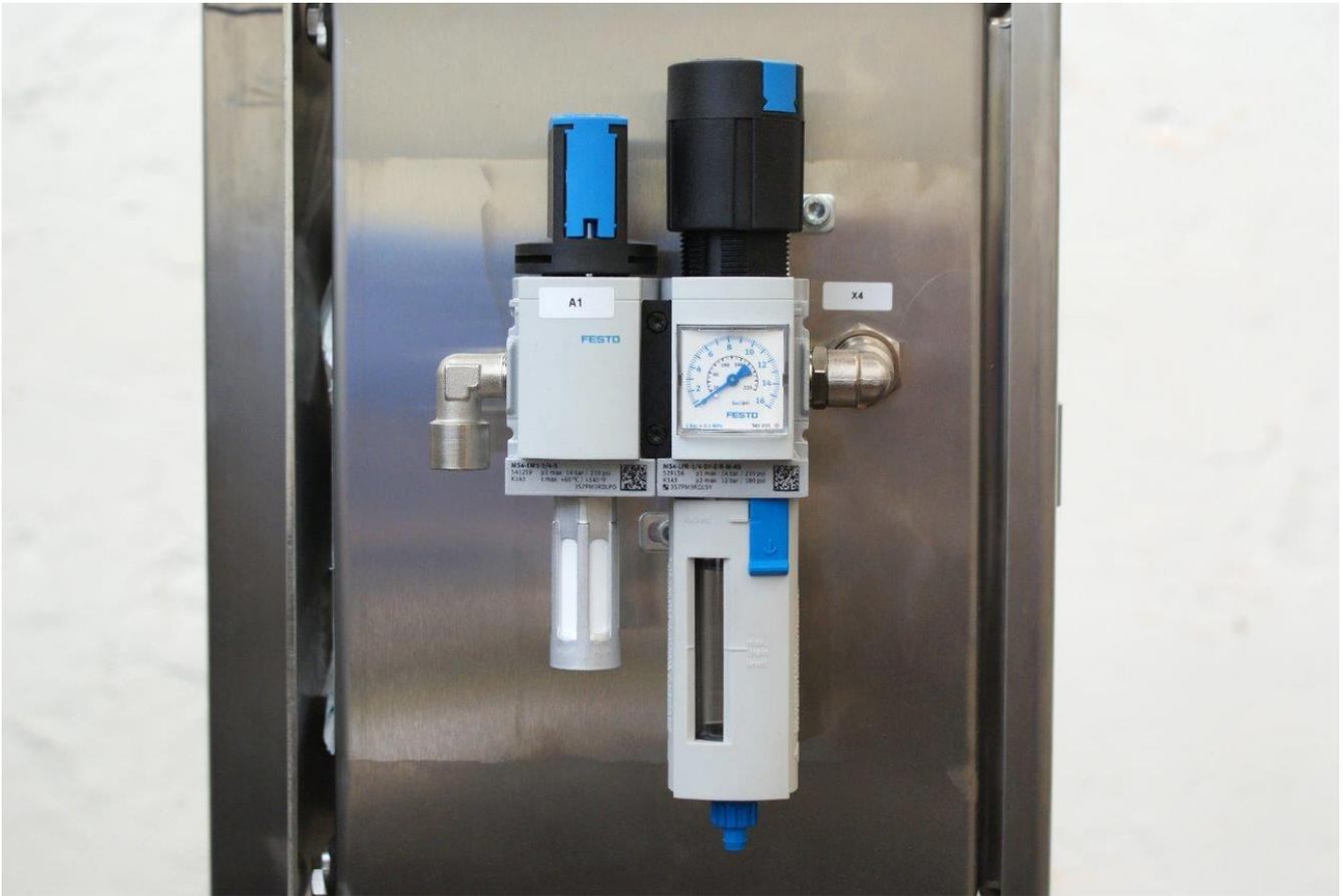
Auf den Edelstahl-Schränken wurde jeweils eine MS4 Wartungseinheit für die Aufbereitung der Druckluft verbaut
