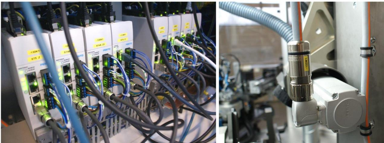
Geregelt werden die Antriebe über die raumsparenden [CMMT-AS](#), die im Schaltschrank und auch auf dem Drehtisch in der Mitte der Anlage verbaut wurden. [EMMT E-Drives](#) mit Absolutswertgeber und einer Einkabellösung sorgen für Bewegung auf der Maschine.
